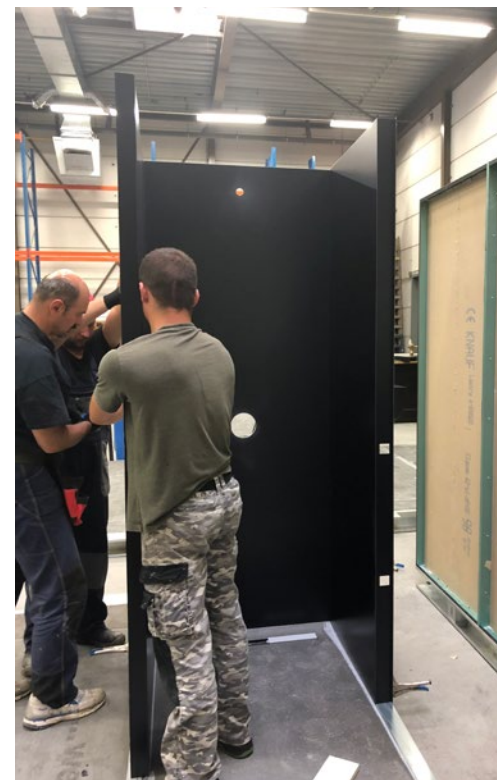
▲ De badkamermodules worden in optimale omstandigheden door vakmensen geassembleerd.
