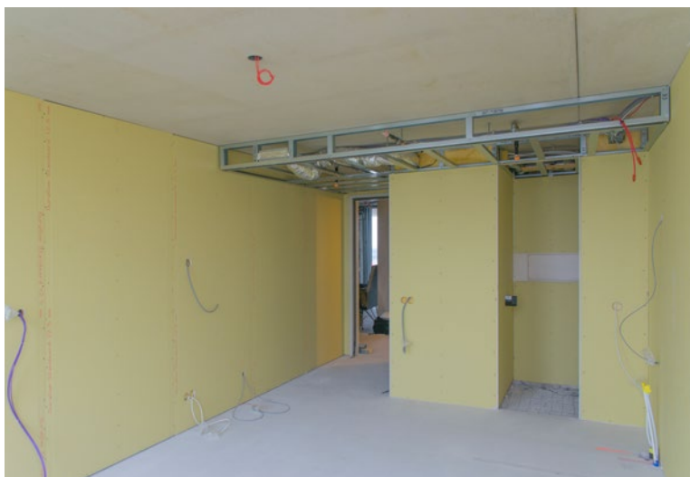
▲ Gyproc produceerde alle platen op maat, inclusief de openingen voor stopcontacten en leidingdoorvoeren.
