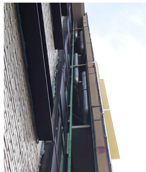
▲ De nieuwe gevelelementen werden aan de bestaande balkons bevestigd, waardoor een spouw ontstond waarin het volledige ventilatiesysteem D kon worden geïntegreerd.
