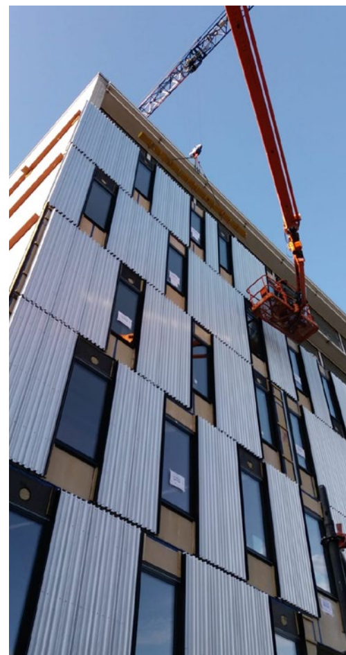
▲ Een kostenefficiënt voordeel van prefab: er zijn geen stellingen nodig. De kant-en-klare modules worden met een kraan en hoogtewerker gemonteerd.
