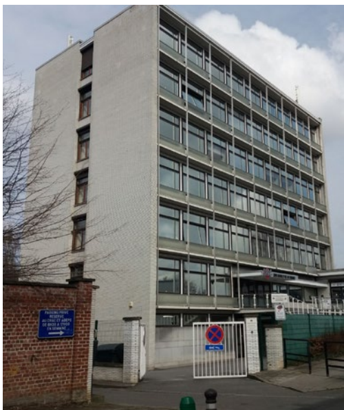
▲ Het CRAC werd zowel binnen als buiten in een nieuw kleedje gestoken zonder dat de ambtenaren het gebouw moesten verlaten.
