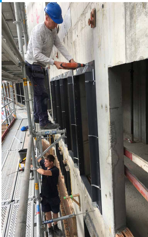
▲ Doordat de EMS-profielen tegen de binnenschil zijn gemonteerd, was er meteen een vaste maatvoering.
