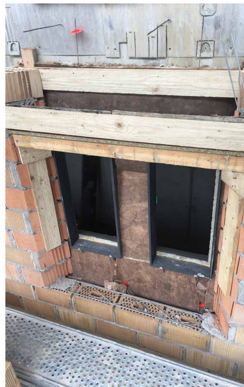
▼ De landmeter zette zowel de kaders als de positie van de bakstenen uit: een ingewikkelde puzzel met veel referentiepunten.
