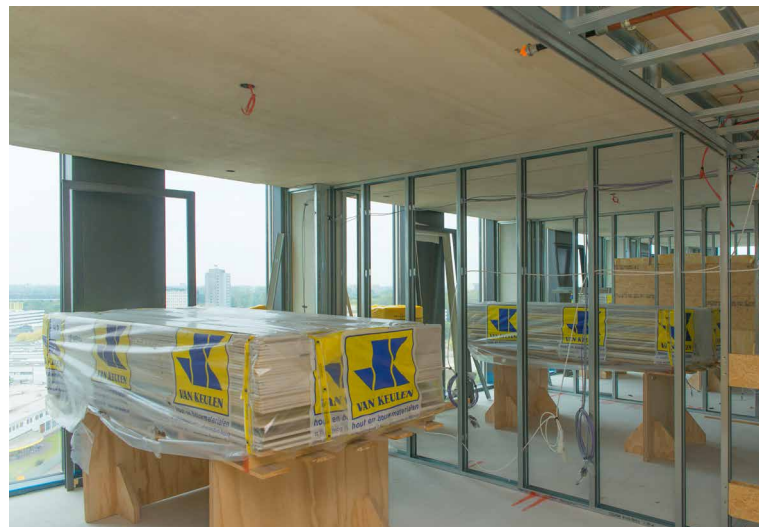
▲ Elk stuk werd genummerd en op volgorde verpakt, zodat de uitvoerder de wanden erg snel, stofvrij en zonder snijafval kon plaatsen.
