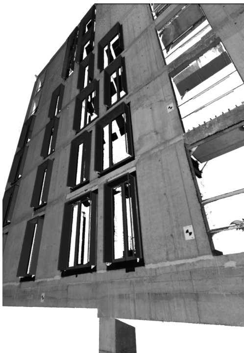
▲ Puntenwolk verkregen via laserscanning (referentiemodel).
